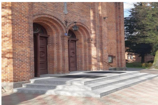
Wyremontowane schody do Kościoła pw. Trójcy Świętej w Książkach
