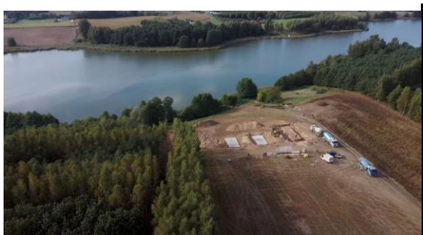
Prace budowlane nad jeziorem w Osieczku
