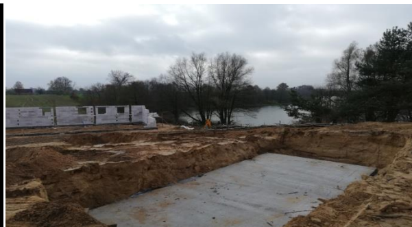
Prace budowlane nad jeziorem w Łopatkach
