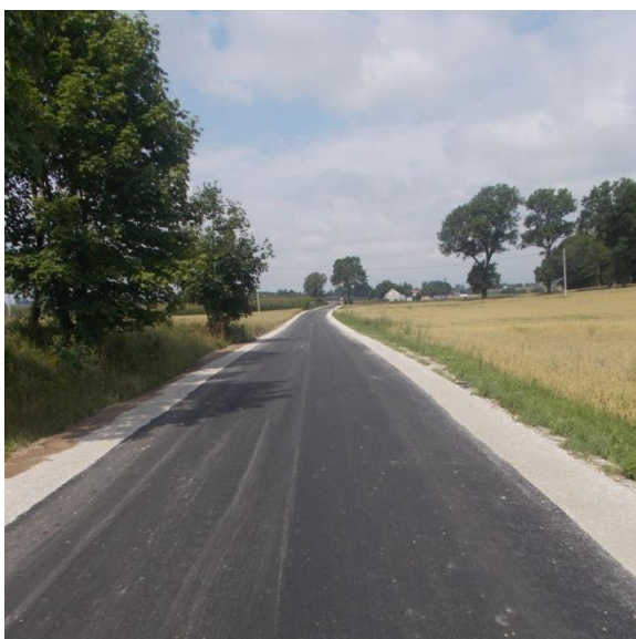
Przebudowa drogi gminnej w miejscowości Blizno
