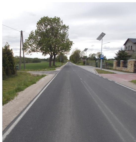
Przebudowa drogi powiatowej nr 1710C
